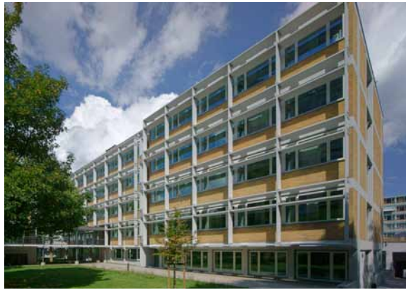
Die Südfassade mit den charakteristischen ‚Brise-soleils‘ Foto: Reinhard Wegmann
