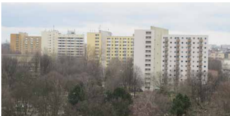
Vier der fünf Punkthochhäuser nach der Fassadensanierung 2015 (Bilder: Peter Michelis)
