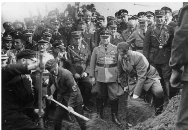
Der erste Spatenstich bei Frankfurt wurde von den Nationalsozialisten propagandistisch inszeniert und von Adolf Hitler ausgeführt (Foto: Bundesarchiv, Bild 183-R27373, CC-BY-SA 3.0)
