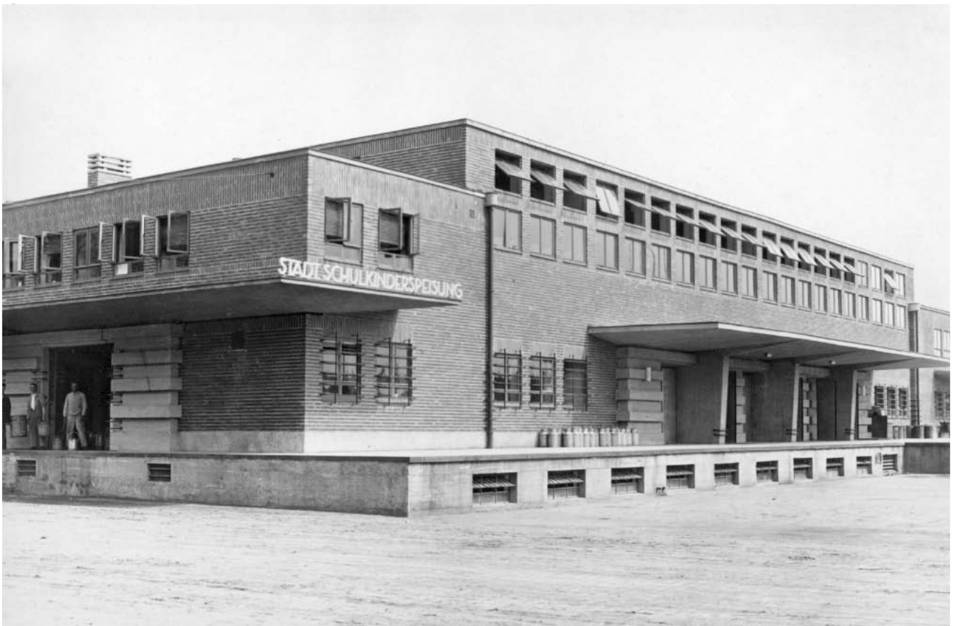
Großmarkthalle, Zentralküche der Städtischen Schulkinderspeisung (Foto: Martin-Elsaesser-Stiftung)
