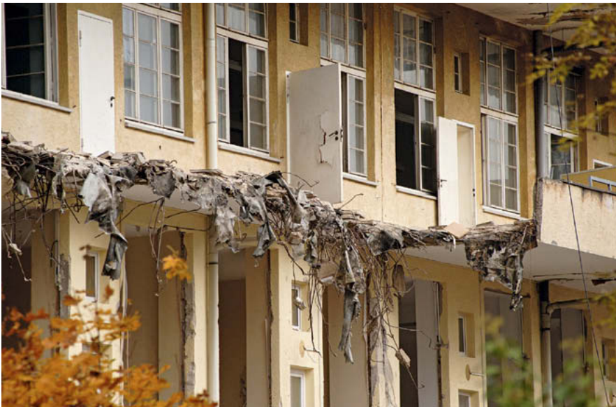
„Altes Krankenhaus“ Schweinfurt, Abbruch November 2011 (Foto: Klaus Noesner)
